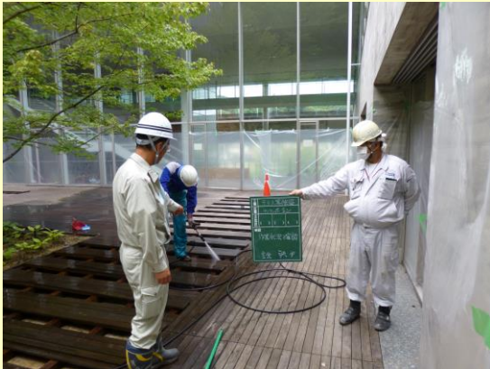
除染現場での立会い
