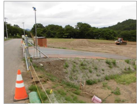
工事用道路に敷設する敷鉄板
