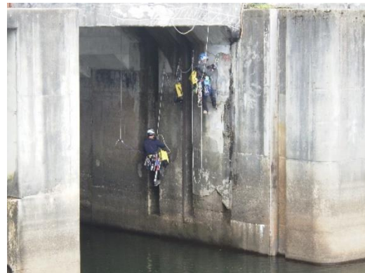
橋台前面の近接目視点検状況
