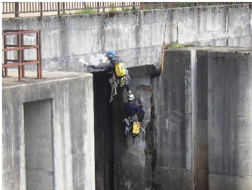
上部工側面の触診・打音検査状況
