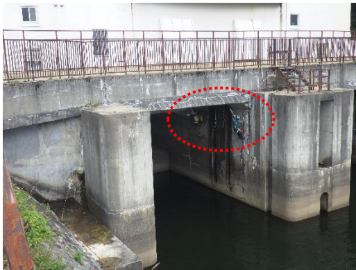
ロープアクセスによる点検状況の遠景
