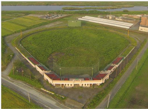
災害復旧工事施工前
