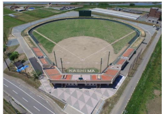
災害復旧工事完了後
