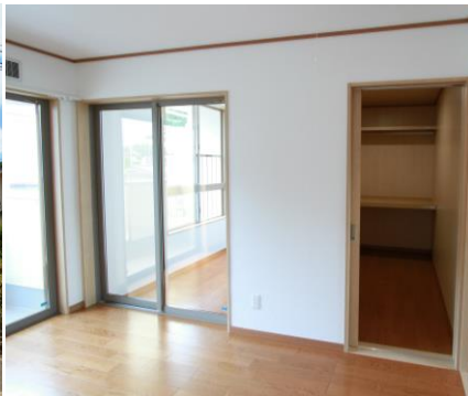
(左) 中畑団地（集合型4戸、木造）の外観。 (右) 2階の洋室から撮影。サンルームとウォークインクローゼットを配置した。
