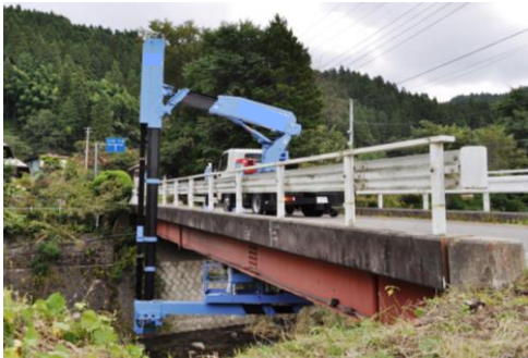
ゴンドラを橋梁下へ差込む
