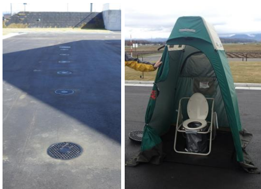
(左) 管理汚泥棟の後ろ側に設置したマンホール6基 (右) 仮設トイレ設置例
