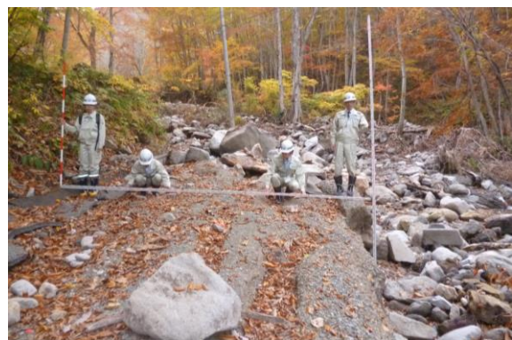
被災箇所の現地調査（南会津町 町道東106号線）
