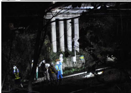
上：跨道橋点検時の規制状況 下：跨線橋点検時の線路内点検状況
