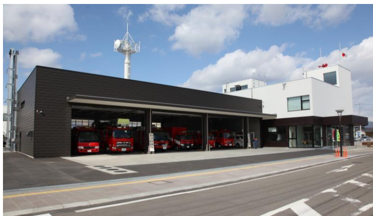
(上 段) 新庁舎外観 (東側)
