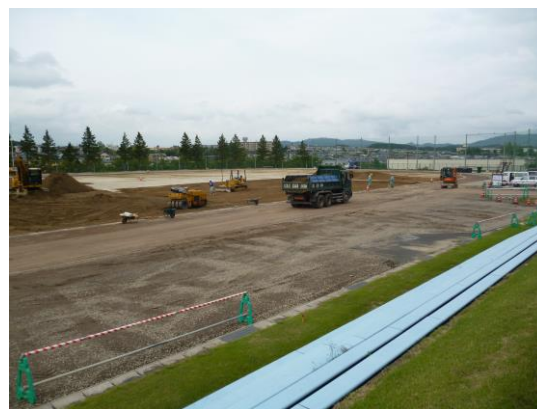
復旧工事が進むグラウンド
