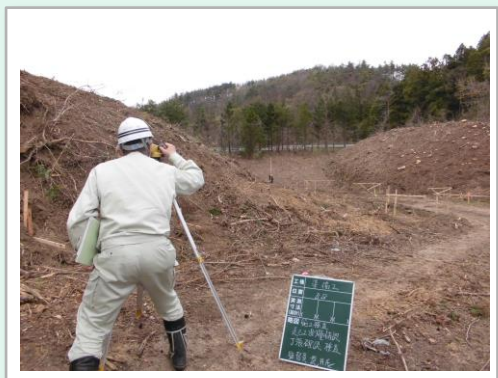
施工検査中の荒井さん
