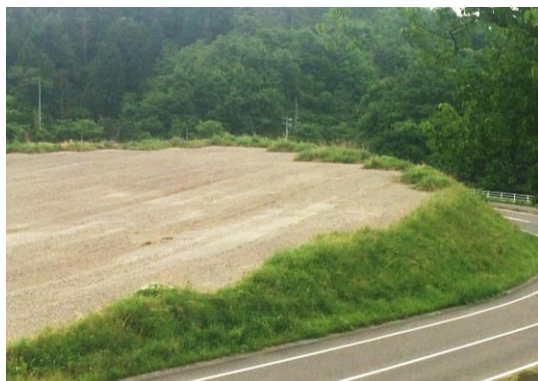
造成工事が竣工した施設建設予定地
