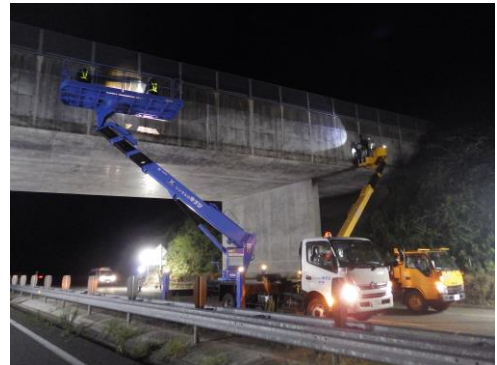
高所作業車2台での点検（常磐自動車道）
