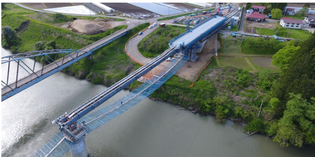
手延桁がP1橋脚に到達した時の様子（東から撮影）。新橋は旧橋の東（上流）に架けられる。
