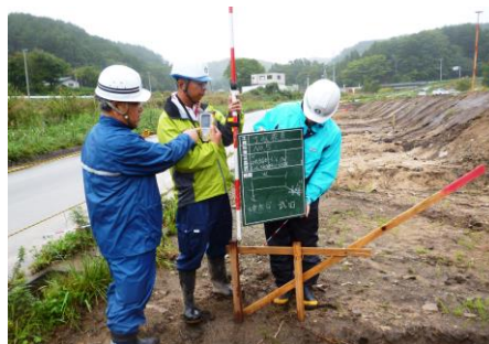
盛土法丁張の立会検査
