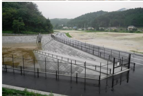
上／施工中 下／竣工後
