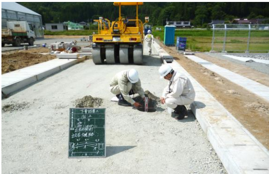
造成工事の現場管理業務
