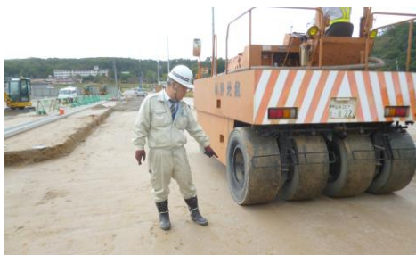
ブルーフローリングによる確認
