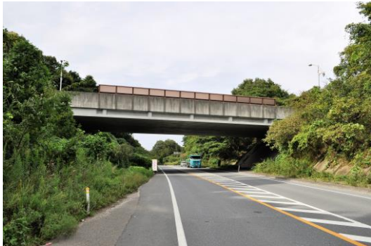
定期点検の対象に含まれている町道橋
