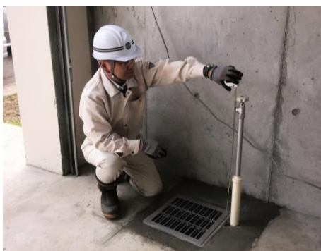
車庫の給水設備の設置状況を確認する渡辺さん
