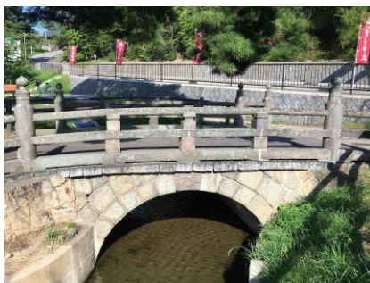
信夫山南麓に保存されている旧祓川橋
