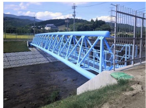
原セ日照田地内水管橋
