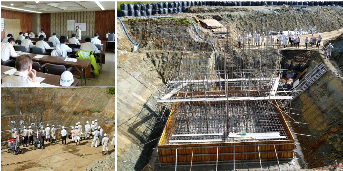
(左上) 熱塩加納支所での講義、(左下・右) 現場見学 (A2下部工フーチングの配筋・型枠設置作業中)
