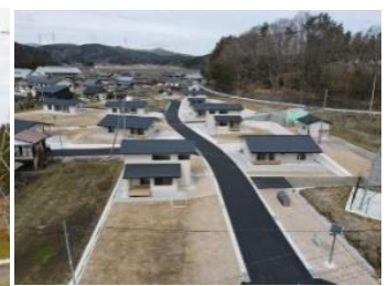
施工完了 (ドローン撮影)
