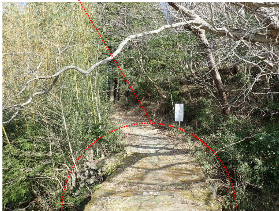
(旧バチサク橋:施工前) 起点から終点方向
