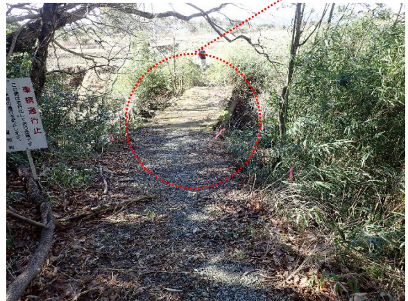
(旧バチサク橋:施工前) 終点から起点方向
