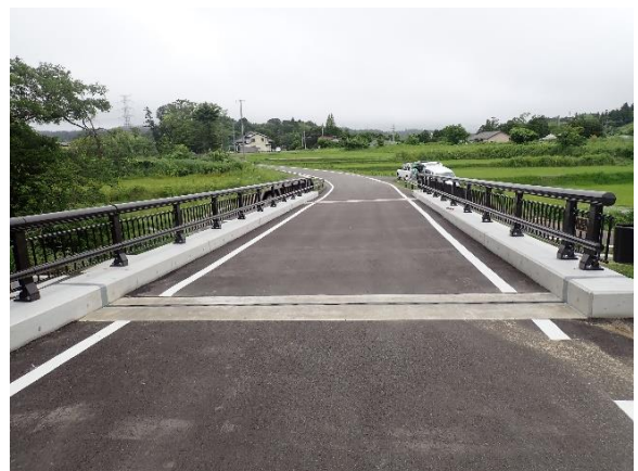
(新バチサク橋:竣工) 終点から起点方向
