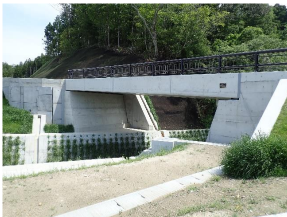
(新バチサク橋:竣工) 橋梁全景
