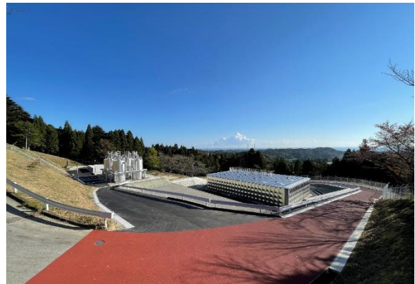
(竣工後:修繕した急速ろ過設備(奥)及び新設配水池)
