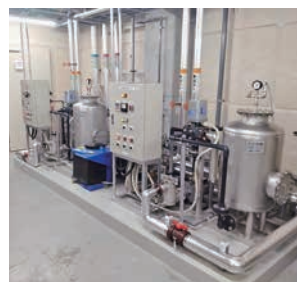
福祉施設給湯設備改修工事(設計・積算・工事監理業務)
