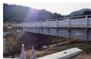
橋梁架替工事 (積算・現場管理業務)
