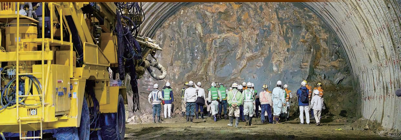
トンネル新設工事（積算・発注者支援業務）
