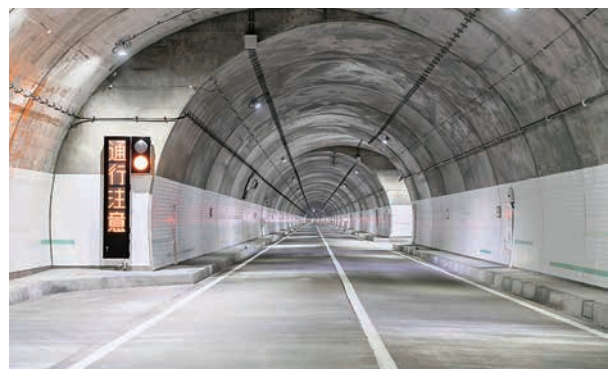
トンネル電気・機械設備整備工事(積算・工事監理業務)
