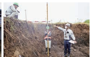
工業団地造成工事 (設計積算・現場管理業務)
