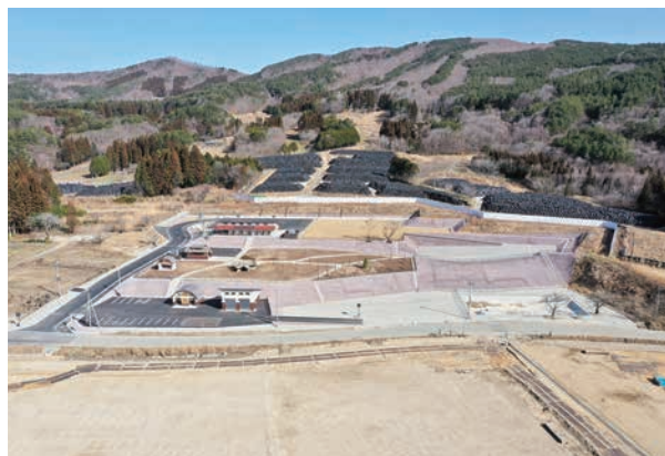
復興関連施設造成工事（設計・積算・現場管理業務）
