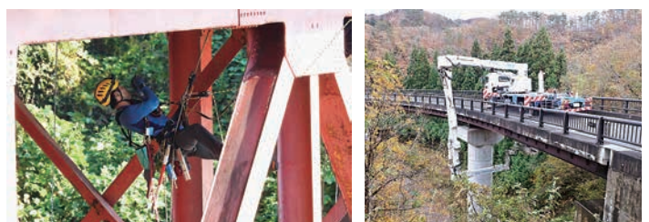
橋梁点検業務 (ロープアクセス工法) 橋梁点検業務 (大型点検車による点検)
