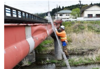
富岡町水管橋点検業務
