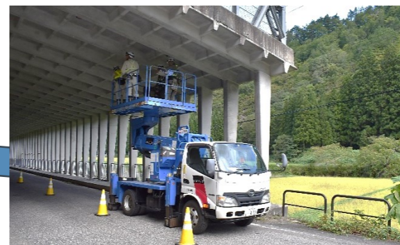
只見町塩ノ岐スノーシート点検業務
