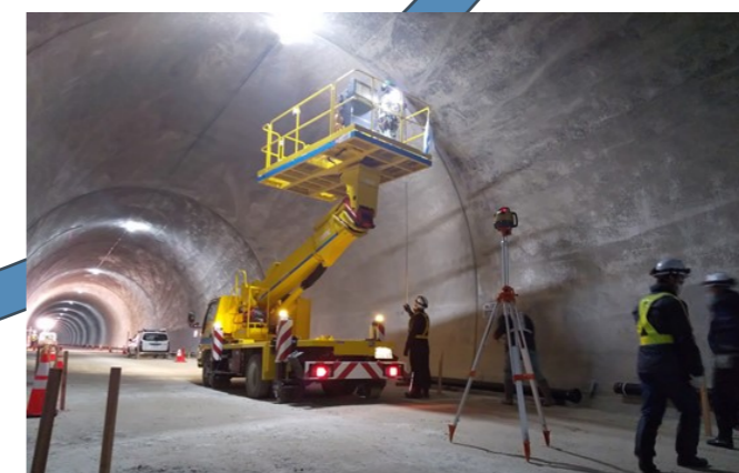
道路橋りょう整備工事(博士トンネル設備工事) (積算・工事管理)
