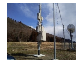
昭和村ラジオ難聴解消事業(積算・工事管理)
