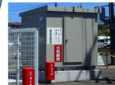
須賀川地方広域消防組 合非常用電源設備工事 (設計・積算・工事管理)
