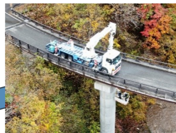
飯館村堰堤橋点検業務
