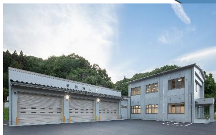
石川消防署庁舎(設計・積算・工事監理)
