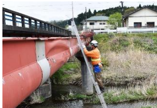
富岡町水管橋点検業務
