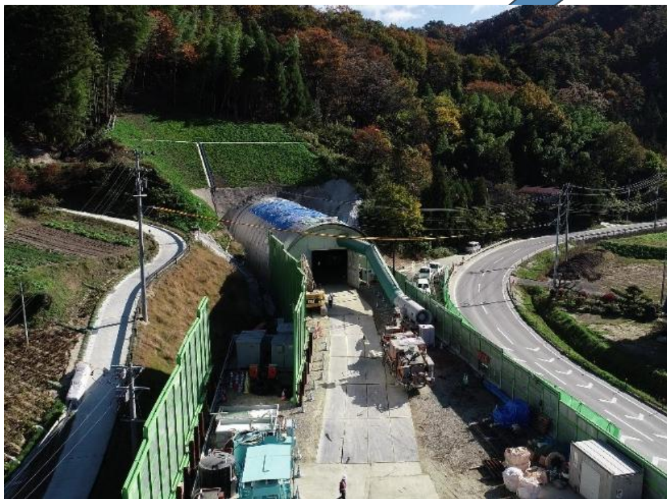
福島県国道 114 号関場トンネル本体工事(積算・監督員支援)
