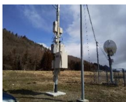
昭和村ラジオ難聴解消事業(積算・工事管理)
