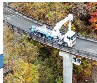
飯館村堰堤橋点検業務
